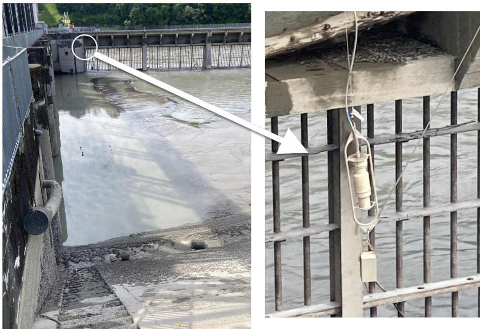
Abbildung 2: Die Nal-Sonde in Chancy ist oberhalb des Kraftwerks in einer Tiefe von normalerweise 3 m installiert. Während dem Absenken des Wasserstands der Rhone um Sedimente hinter der Verbois-Staumauer auszuspülen (APAVÉR 2025) hing die Sonde während gut 2 Wochen in der Luft.
